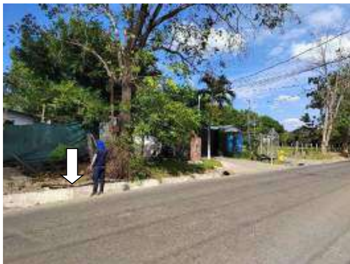
Fotografía 5: Revisión de sitio con coordenadas 342499 Este / 271484 Norte.
