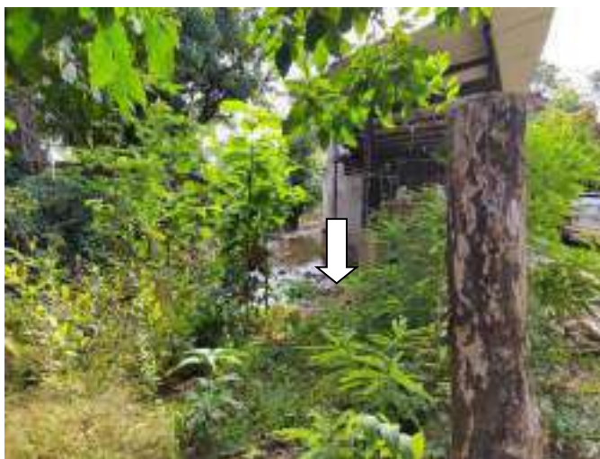
Fotografía 13: Revisión de sitio con coordenadas 342512 Este / 271686 Norte.
