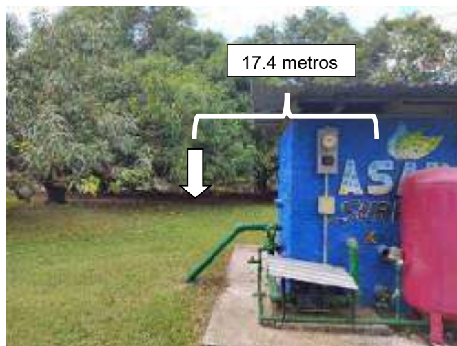
Fotografía 7: Revisión de sitio con coordenadas 343075 Este / 270076 Norte.
