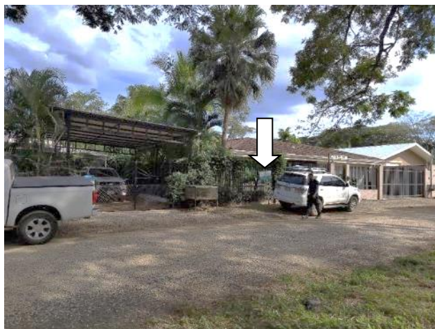
Fotografía 16: Revisión de sitio con coordenadas 342990 Este / 269890 Norte.
