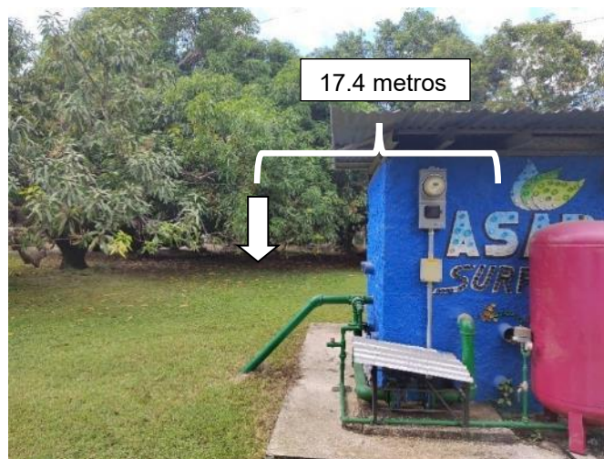
Fotografía 7: Revisión de sitio con coordenadas 343075 Este / 270076 Norte.
