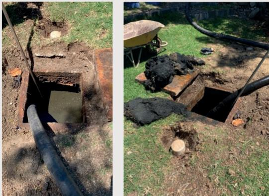
Remoción de materia flotando, mezclada y remoción de materia fecal, en tanque séptico de una vivienda. E. Rosales
