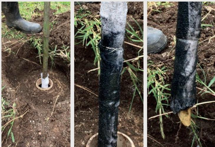
Proceso de verificación del nivel de lodos en un tanque séptico. Al introducir una vara con tela de paño amarrada en su extremo inferior. Los lodos se impregnan, distancia que se mide en la vara y compara con el nivel de líquidos en el tanque, como con la posición registrada para la boca inferior de la salida hacia el drenaje. E. Rosales E.
