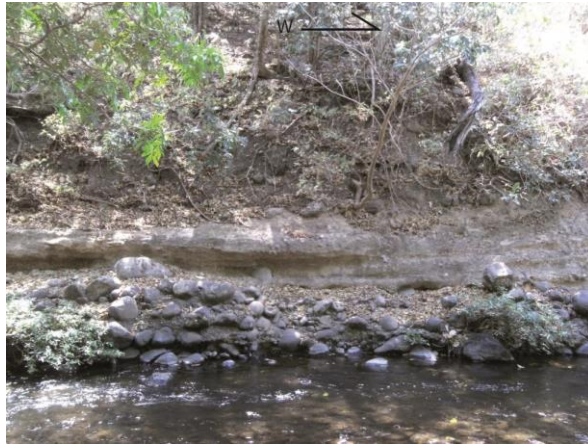
Foto 23. Materiales re trabajados en el río Santa Rosa, nótese la erosión diferencial del material en la parte superior.
