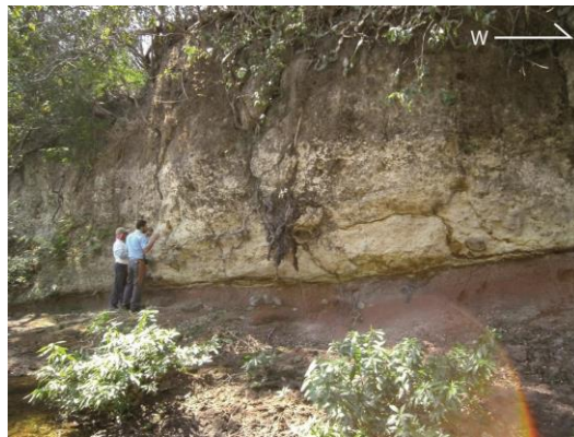
Foto 4. Flujo no soldado en estado meteorizado, coloraciones blancas en la matriz muy arcillitizada.
